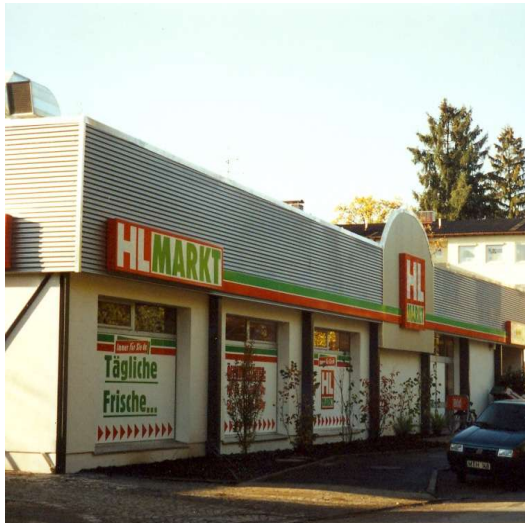
Der bestehende Markt wurde mit neuer Stahlkonstruktion überspannt
